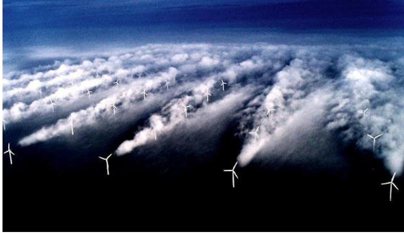
Şekil 3. Deniz Üstü RES'lerde Meydana Gelen İzbölgesi Kaynak: Önel, H., C. (2019)
