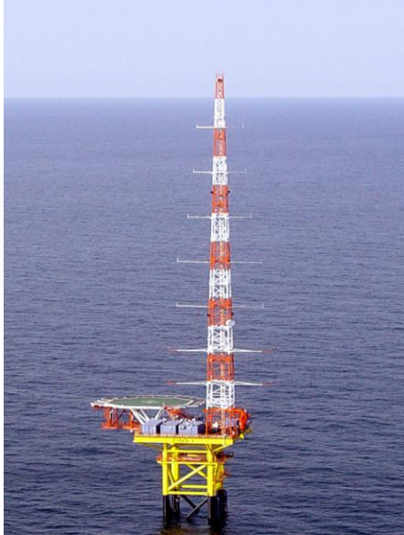
a) Sabit temelli rüzgâr ölçüm direği Kaynak: Munoz-Esparza, D. ve diğerleri 24
