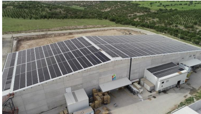
Şekil 16: Bir soğuk hava deposunda çatı GES uygulaması
